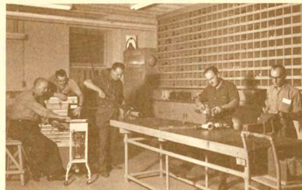
Equipe des plombiers et électriciens
